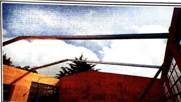
Foto 8: se evidencia el avance de la instalación de la costanera de metal del establecimiento educativo.
