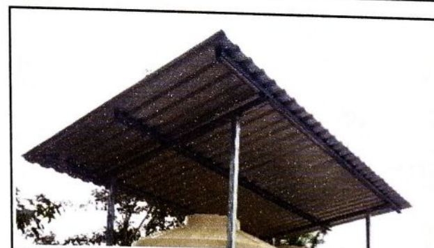
Foto 6: se evidencia en la fotografia la instalacion del techo con laminas troquelada para cubrir el tinaco del establecimiento.
