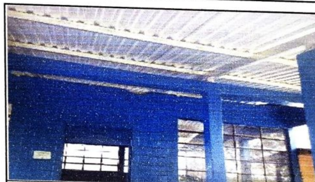
Foto 4: se identifica el avance de la instalacion de laminas troquelada en el corredor de la escuela.
