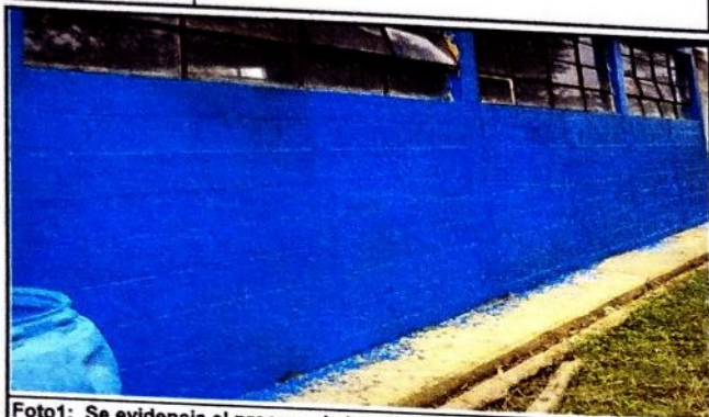
Foto 1: Se evidencia el proceso de la colocacion de pintura en paredes del establecimiento.
