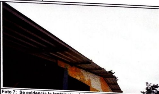
Foto 7: Se evidencia la instalación de láminas troquelada para el techo del establecimiento.
