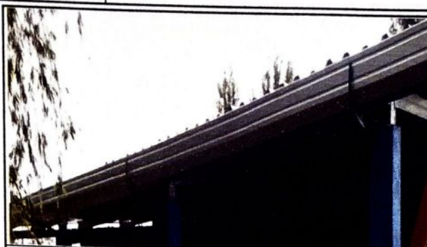
Foto 2: se muestra en la fotografia el avance de la instalacion de canales troquelada para bajada de agua
