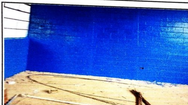
Foto 3: se evidencia el avance de la colocacion de pintura en el interior del establecimiento educativo.
