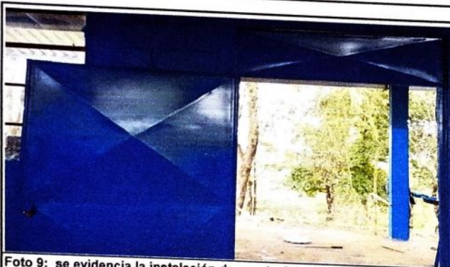
Foto 9: se evidencia la instalación de puerta del establecimiento
